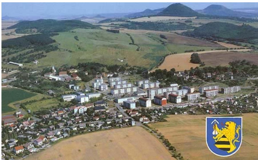
Obr. 2: Letecký pohled na Bečov (Základní škola Bečov, 2013a, on-line)
